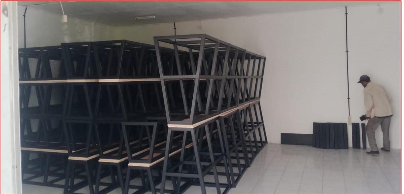
Gambar 10 Abutmen dan Perancah yang akan Digunakan
